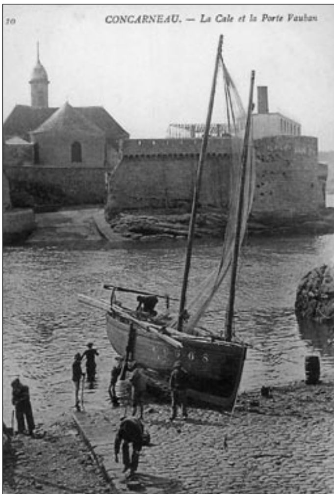
Les 2 cales (ou rampes) pour le Bac côté Ville-close et côté passage.
